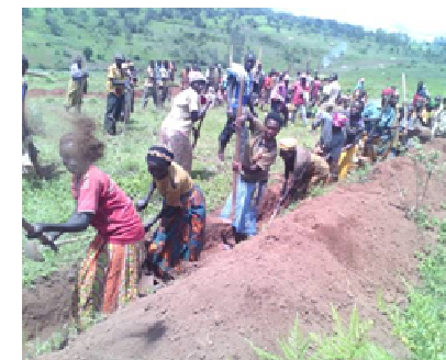
Traçage des courbes de niveau
